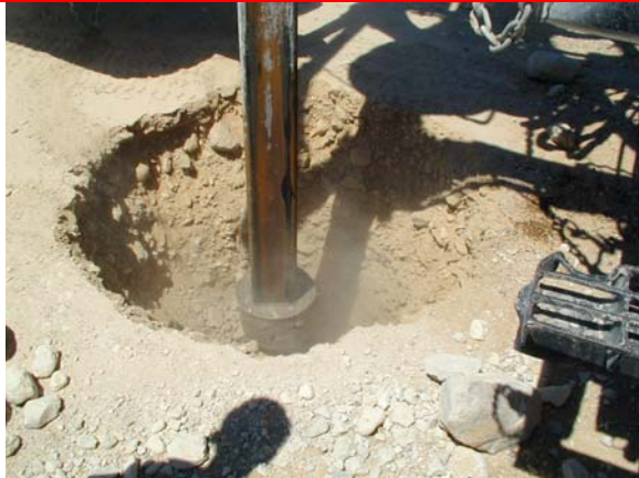
ניסיון קדיחה בק-4 נכשל בגין התמוטטות דפנות הקדוח סמוך לפני השטח. רק לאחר העתק נקודת הקדיחה כ-5 מטר מנקודת המקור הצליח הקודח לקדוח ללא בעיות עד לעומק 11.0 מטר. מתחת לעומק הנ"ל התמוטטות מונעת המשך הקדיחה.
