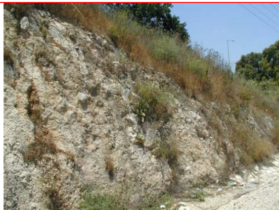
מרכיבי יחידה גיאוהנדסית V כפי שנחשפים בחציבה לצידי דרך 70. המסלע גיר דולומיטי, קשה, משוכב עד עבה, סדוק. מערכת הסידוק בשילוב השכוב ונטייה חריפה גורמים לדרדרת מקומית.
